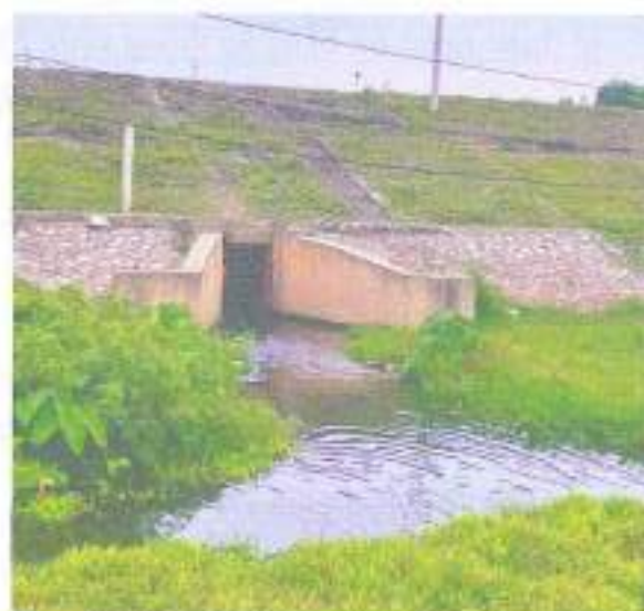
Cống tiêu số 1 gần ranh giới Đông Nam Dự án
