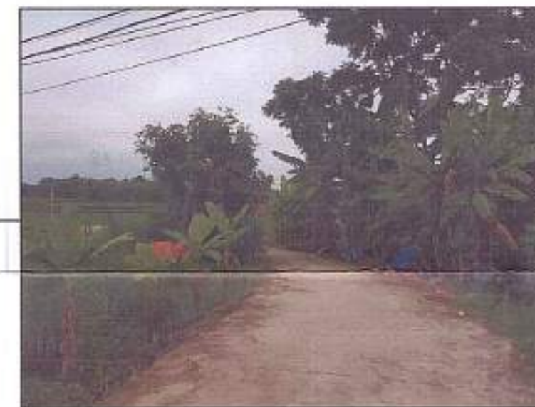
ĐƯỜNG BÊ TÔNG HIỆN TRẠNG
